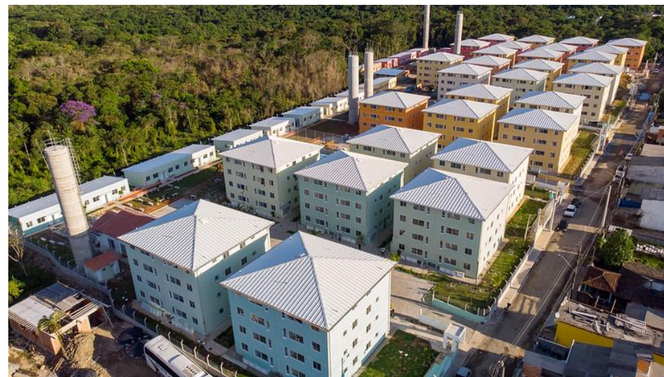
Atendimento CDHU a famílias em áreas de risco, Empreendimento Baleia Verde – São Sebastião. Fonte: CDHU.
