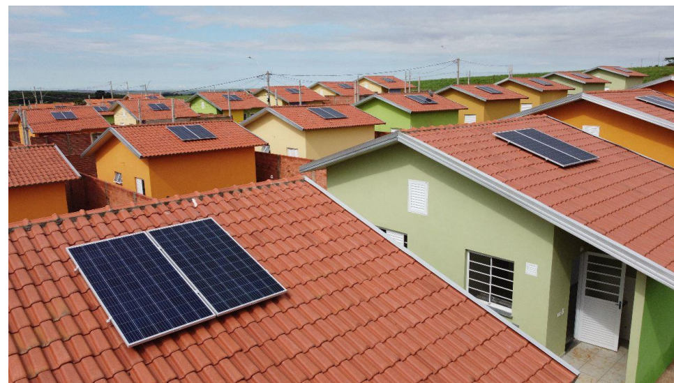
Fonte: Divulgação CDHU - placas fotovoltaicas em casas populares.
